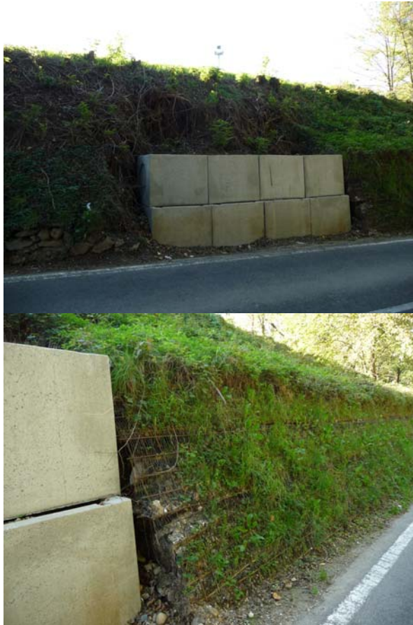
Figura 9.1 – Cubi in calcestruzzo di contenimento in via Cesare Battisti
